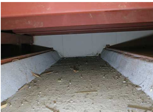
祭壇ステージ下 (段差)
